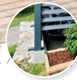
Maçonnerie adaptée à la topographie du terrain
