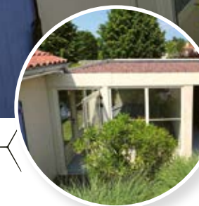
Création d'un atelier fermé
